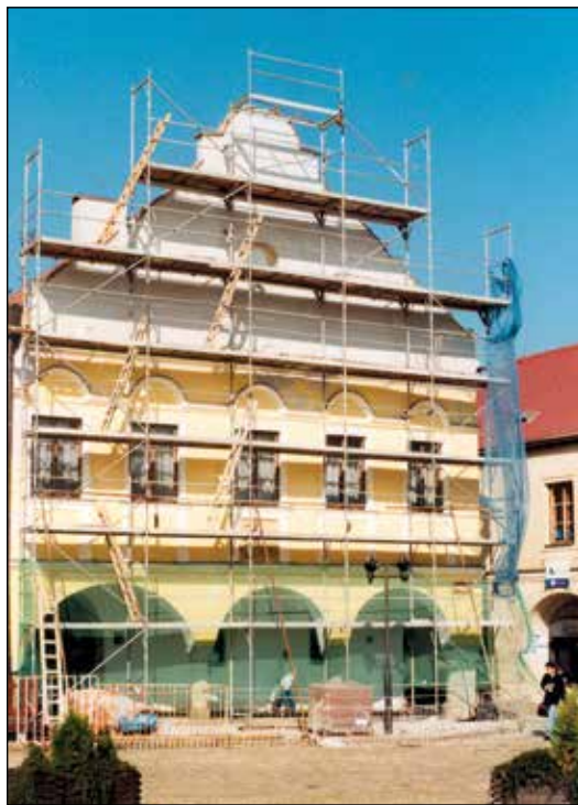
Renovace štítu budovy radnice.
