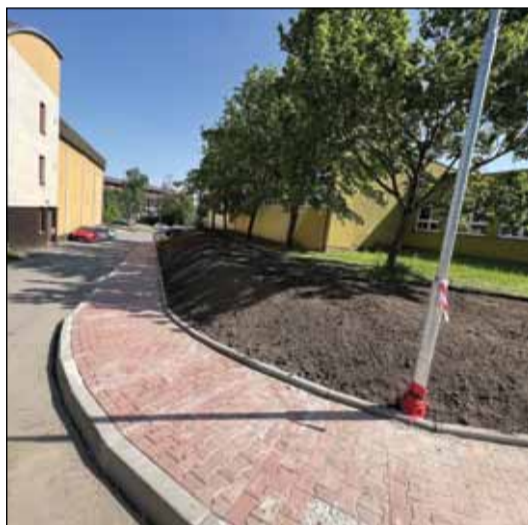
Chodníky a parkoviště. Větší bezpečnost přinesl obyvatelům nově zhotovený bezbariérový chodník přidružený ke stávající místní komunikaci u ulice U Stínadel v Pelhřimově v celkové délce 114 metrů. Součástí projektu byla také rekonstrukce veřejného osvětlení. Kromě výstavby nových myslí radnice i na rekonstrukce stávajících chodníků. Rekonstrukce chodníku a parkoviště se uskutečnila například v ulici Tábořská před obytnými budovami č.p. 1809 – 1811.
