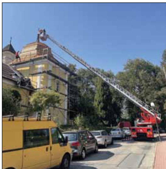
Objekt kaple sv. Floriána s ambity v poutním areálu centrální kaple Panny Marie Bolestné umístěné v Pelhřimově, třída Legií č.p. 329 se dočkal v loňském roce výměny šindelové střešní krytiny, která byla v nevyhovujícím stavu. Nově byla osazena dvojitá šindelová modřínová krytina Valašského typu na perodrážku. Součástí prací byla také výměna stávajícího hromosvodu, oplechování střešní krytiny a oprava omítek a nátěrů poškozených podstřešních částí a komínu.
