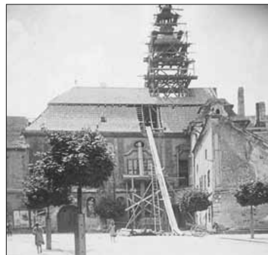
Oprava střechy zámku pánů z Řičan, pohled z proluky mezi domy čp. 10 a 13.
