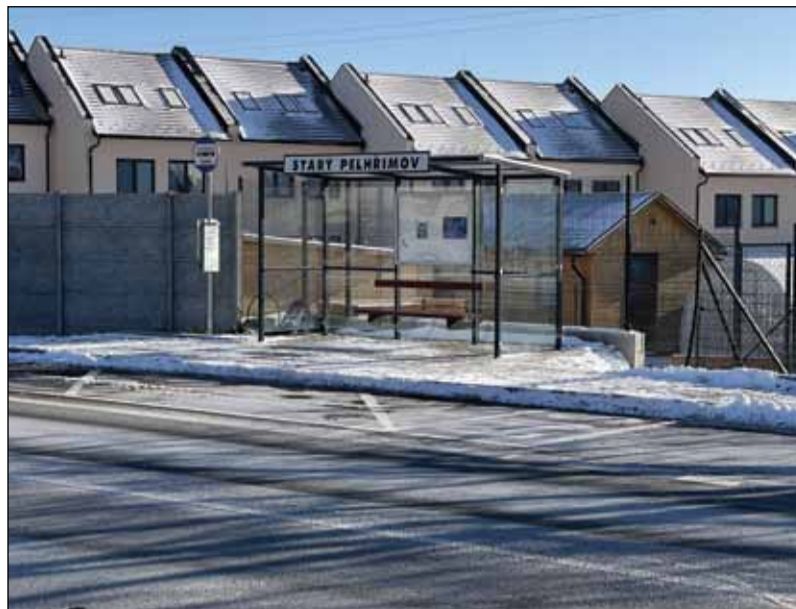
Zklidnění dopravy ve Starém Pelhřimově. Jedná se o komplexní projekt, který řešil zklidnění dopravy ve Starém Pelhřimově a zlepšení podmínek pro obyvatele přilehlé zástavby, pro existenci MHD a městských služeb. Rozsáhlý projekt se uskutečnil ve čtyřech etapách v rámci, nichž vznikly střední dělicí ostrůvky pro zpomalení dopravy na příjezdech do Starého Pelhřimova, nástupiště autobusové zastávky, přechody a chodníky. Součástí byla i rekonstrukce inženýrských sítí - rekonstrukce vodovodu, kanalizace a veřejného osvětlení včetně optické infrastruktury pro dopravní technologii. Tímto projektem se vyřešil dopravně inženýrský problém a zároveň došlo ke zlepšení veřejného prostoru pro pěší.
