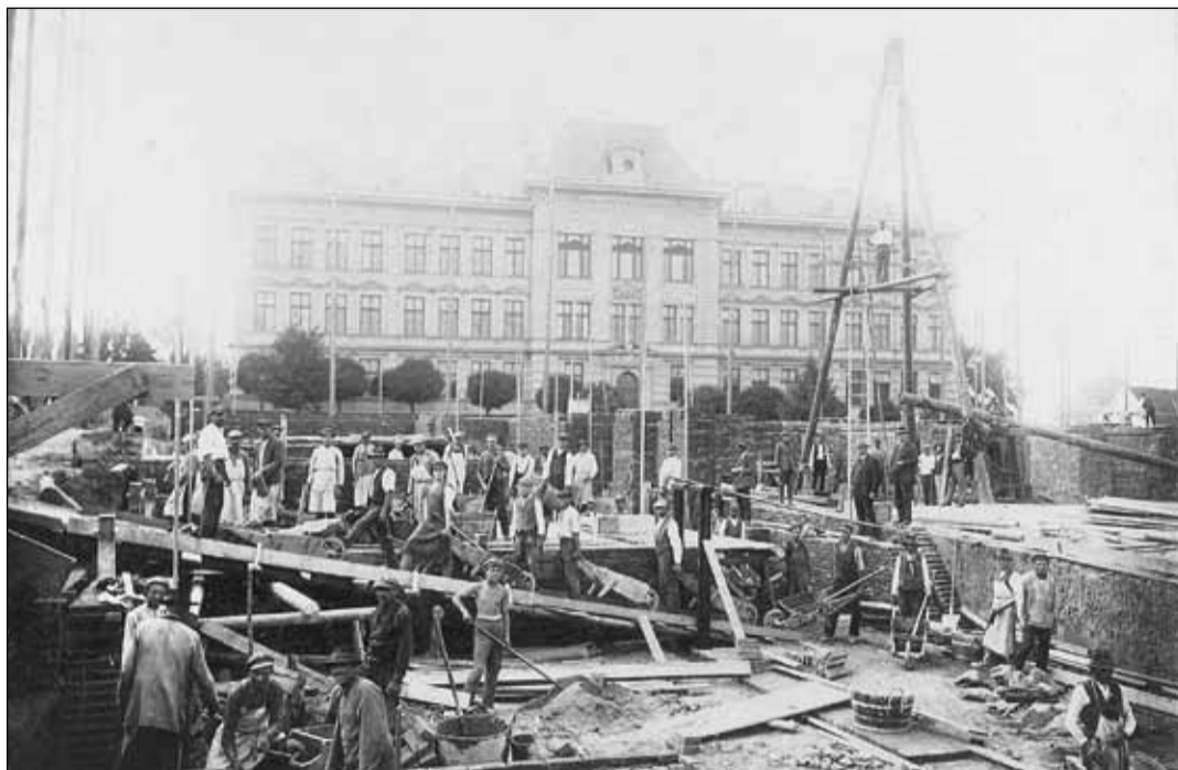
Zahájení stavby Masarykových měšťanských chlapeckých škol, zvedání zdí ze základové desky. V pozadí budova Komenského dívčích škol.
